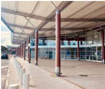
Le parvis de l'aérogare a été entièrement rénové.
