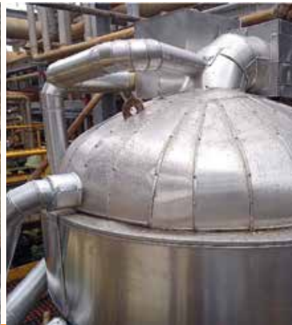
Traçage découpe et repose de calorifuge sur ballon
