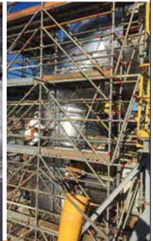
Pose de calorifuge sur tuyauterie de DN 4000
